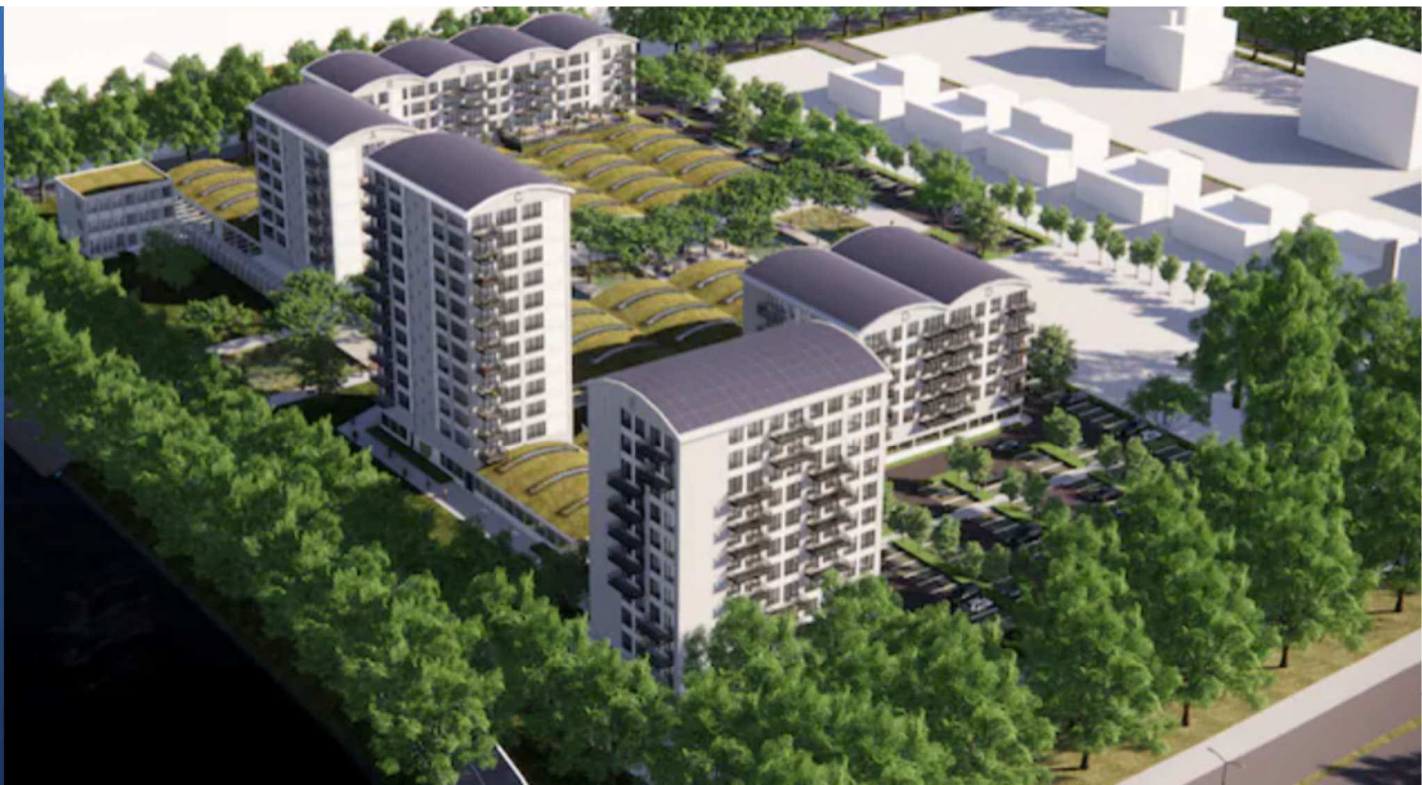
▲ Impressie van bouwlocatie Galvanitas © Grosfeld Bekkers van der Velde architecten
